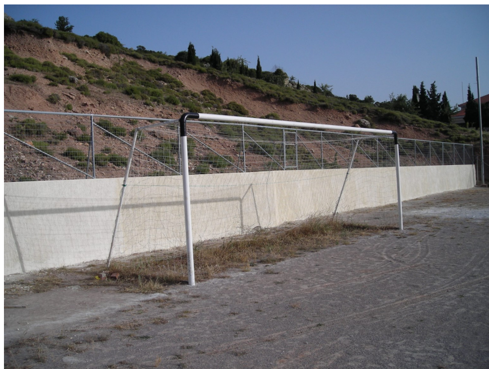
Επισκευή του τοίχου στη νότια πλευρά του γηπέδου
