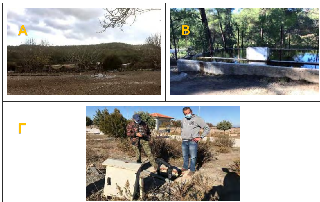
Εικόνα 7 : (Α) η γεώτρηση στο κτήμα Ελευθεράκου (ΚΕΛ-01), (Β) η υδρομάστευση της πηγής (ΛΕΣ-Πο1) και (Γ) η γεώτρηση στην Κλεφτόβιγλα (ΚΛΕΦΤ-01)(εντός του χώρου του ΧΥΤΑ).
